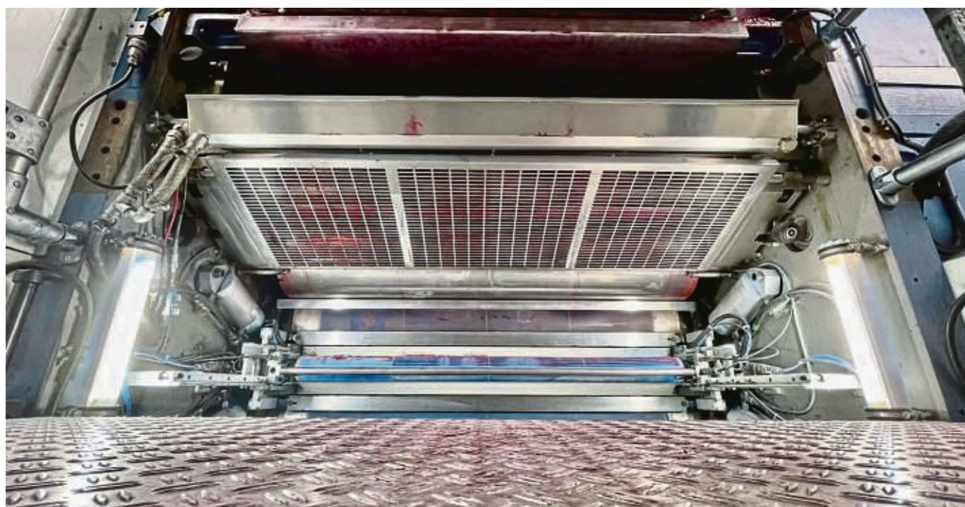
Einblicke in ein Druckwerk in einem der zwei Türme. Pro Turm gibt es acht Druckwerke.
