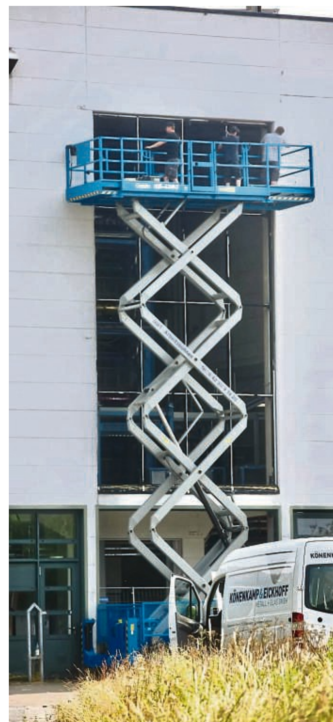
Vor der Entkernung müssen die Fenster entfernt werden.
