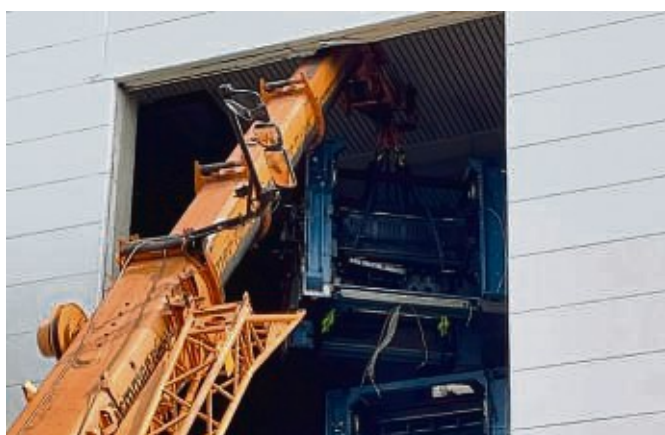
Eng geht's zu beim Herausheben der Druckwerke. FOTO: JAESCHKE
