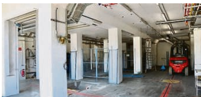
Das Erdgeschoss ist leer geräumt. Dort wurde das Papier eingelegt und gewechselt.
